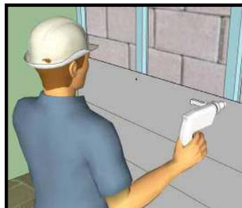
Instale el Siding sobre el perfil Omega con tornillo fit. Recuerde colocar los tornillos según distancias de fijación indicada.
