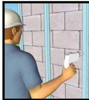
Instale el perfil Omega sobre la pared de concreto con tornillo y expander o clavo de impacto @ 406 mm mínimo ó 610 mm máximo. Recuerde que cada perfil Omega debe estar aplomado.
