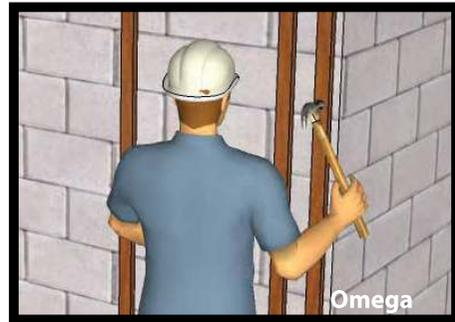
Fije las piezas de Siding a la estructura previamente instalada con clavos de 2" utilizando martillo o clavadora.
